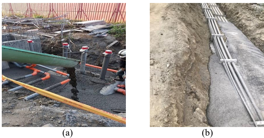
圖 6-5 案例(一)廠房新建工程管路回填((a)澆置中，(b)澆置完成)
