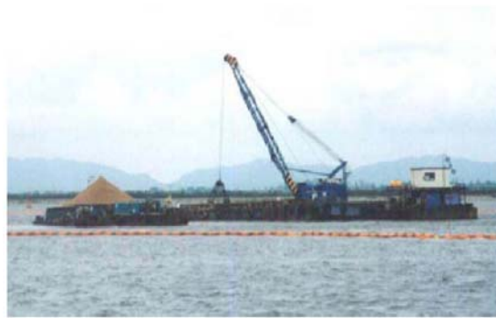
圖 8-8 海洋塊人工魚礁施工現場 [68]
